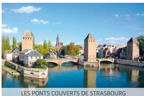
LES PONTS COUVERTS DE STRASBOURG
